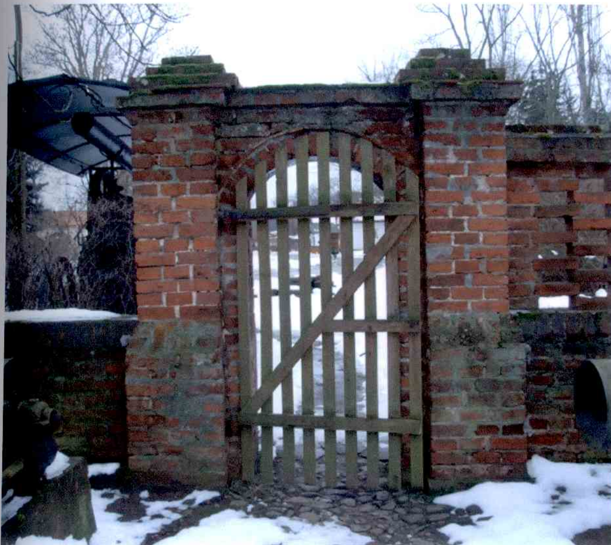
Fot. 10. Ogrodzenie przy wozowni
