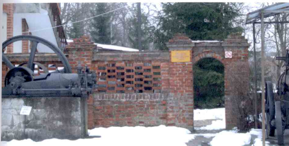
Fot. 9. Ogrodzenie przy wozowni
