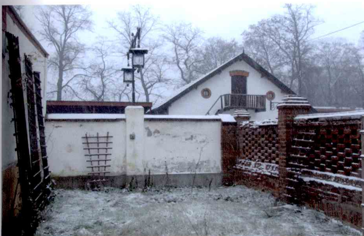
Fot. 3. Ogrodzenie przy stajniach
