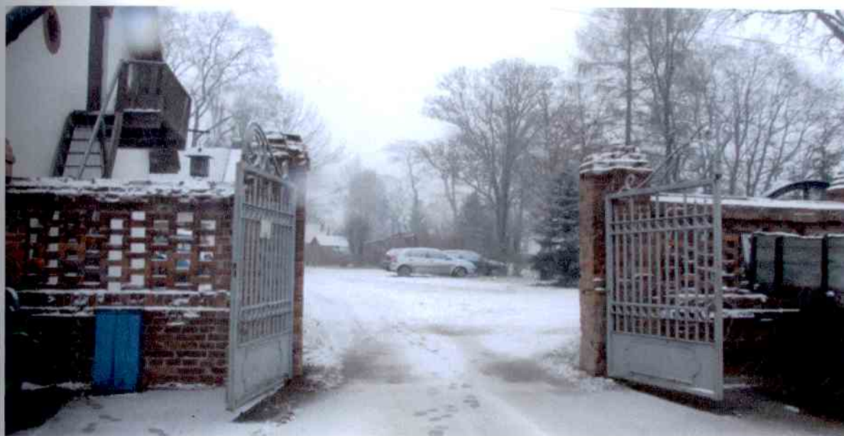
Fot. 2. Ogrodzenie przy stajniach
