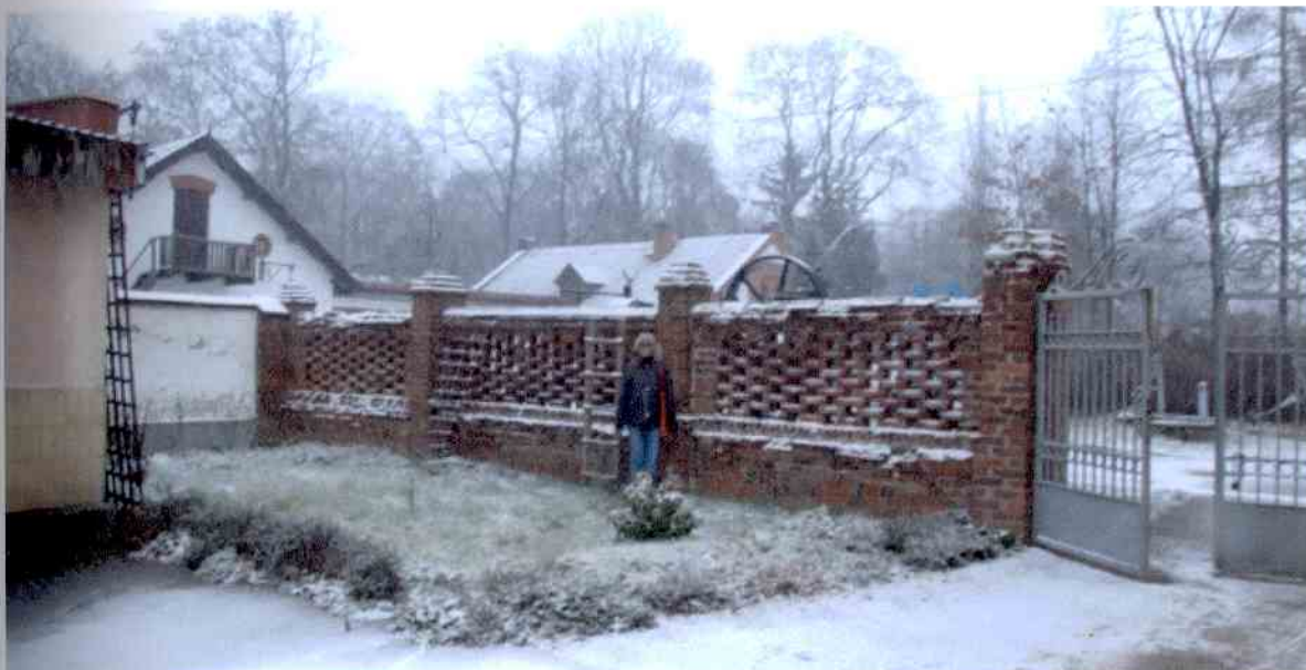
Fot. 2. Ogrodzenie przy stajniach
