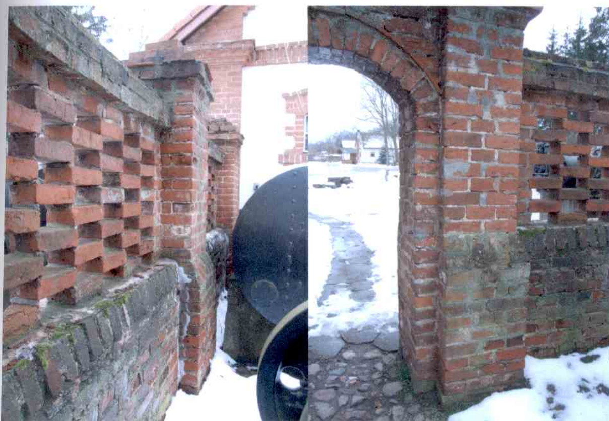
Fot. 11. Ogrodzenie przy wozowni
